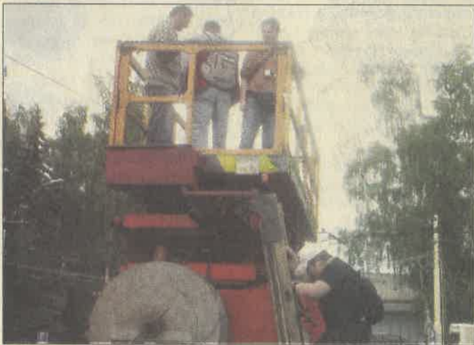
Podívat se na svět z ptačí perspektivy umožnila návštěvníkům věžka na údržbu trolejového vedení.
